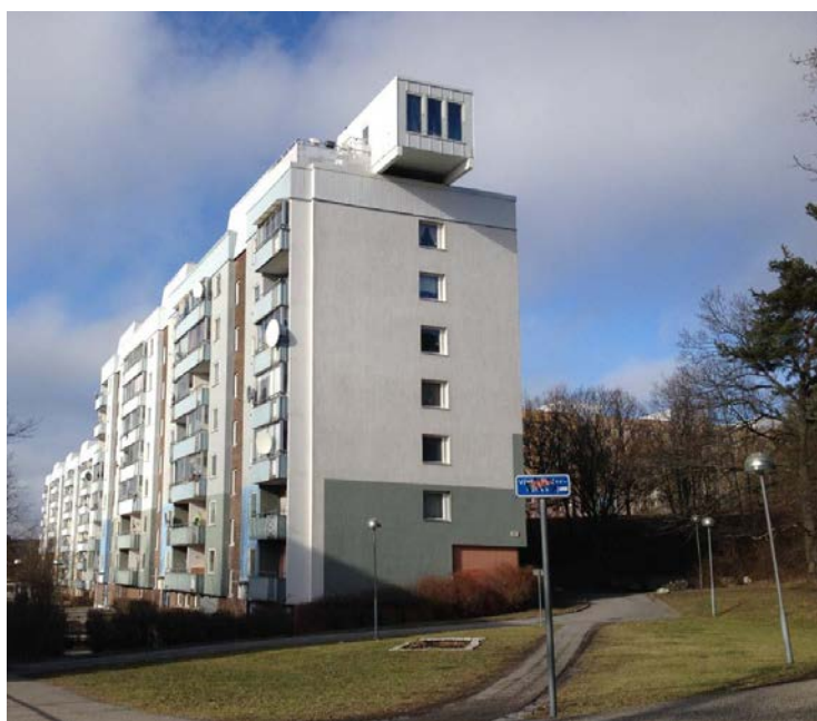
Bild 4. Nyttillkommen påbyggnad på befintlig bebyggelse.
