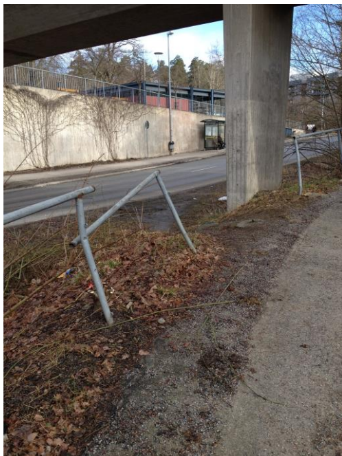
Bild 12. Informell passage över Tingsvägen.
