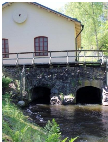
Uddby kraftverk i Tyresåns utlopp uppfördes år 1898.
