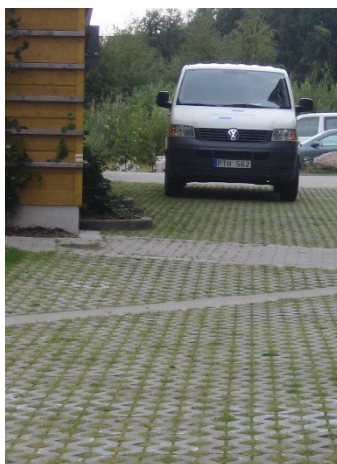
Foto 6.2 Genomsläpplig beläggning på parkeringsplatsen, Växjö kommun.
