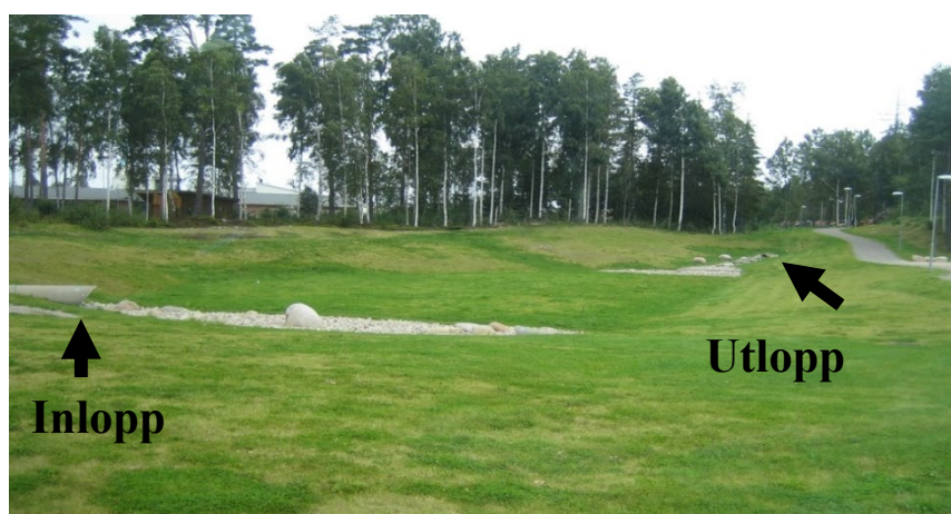
Foto 6.4 Fördröjningsmagasin som används om det regnar mycket, övriga tider är det en plats för lek och rekreation. Växjö kommun.
