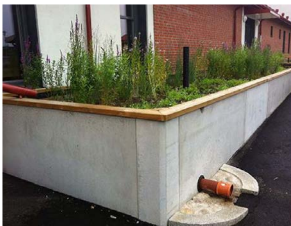
Figur 17. Upphöjd växtbädd i anslutning till byggnad. (Bildkälla: baramineraler.se)
