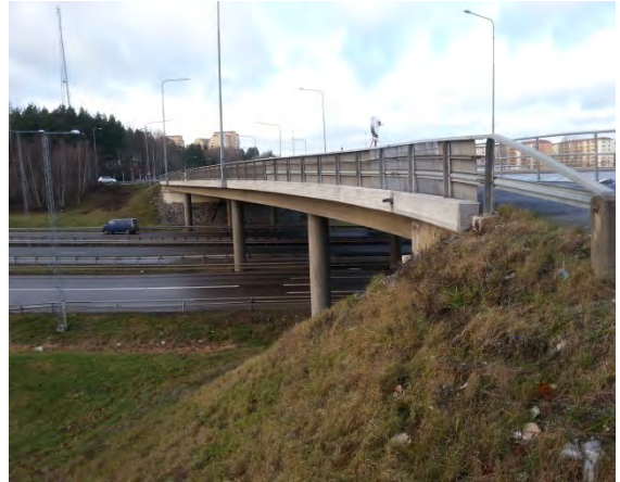
Vägbro över E4E20, Hallundavägen
