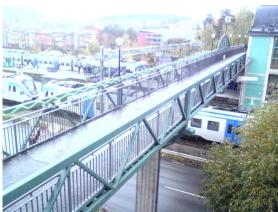
Gångbro över spårområdet i Tumba Centrum
