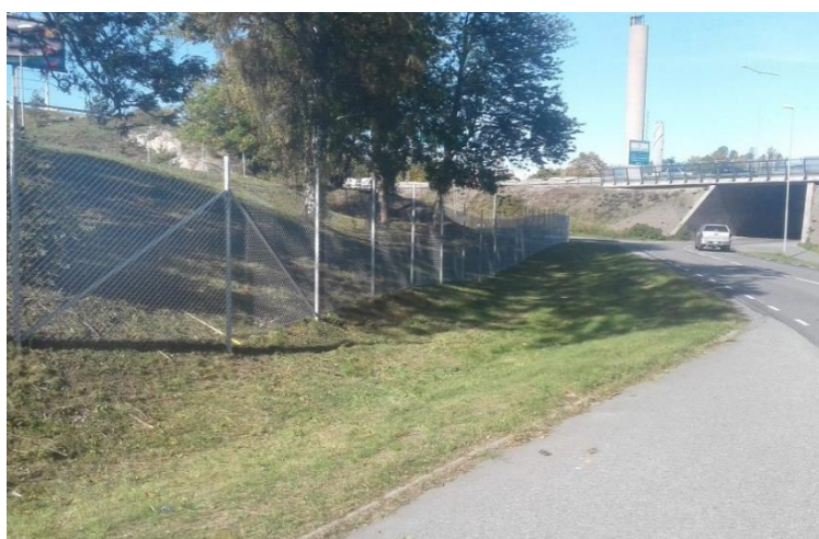
Bild 4. Den befintliga slänten mot E4/E20.
