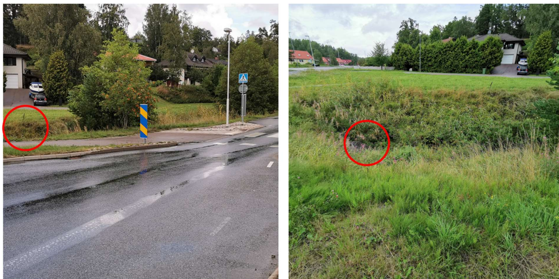
Figur 10. TV: Krondike i förhållande till övergångsställe i norra delen av Nibblevägen. TH: Foto ned mot krondiket med mycket vegetation med stor kulvert i botten, uppskattad till en dimension på 1600 mm.
