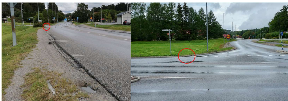
Figur 9 TV: Nibblevägen blickandes nordöst med mottagande dagvattenbrunn inringad där vägdiket i vänstra delen av bilden sannolikt inte tar emot vägdagvatten från Nibblevägen. TH: Korsning Nibblevägen/Nibblebacken blickandes upp mot Nibblebacken (nordväst) med inringad mottagande dagvattenbrunn.
