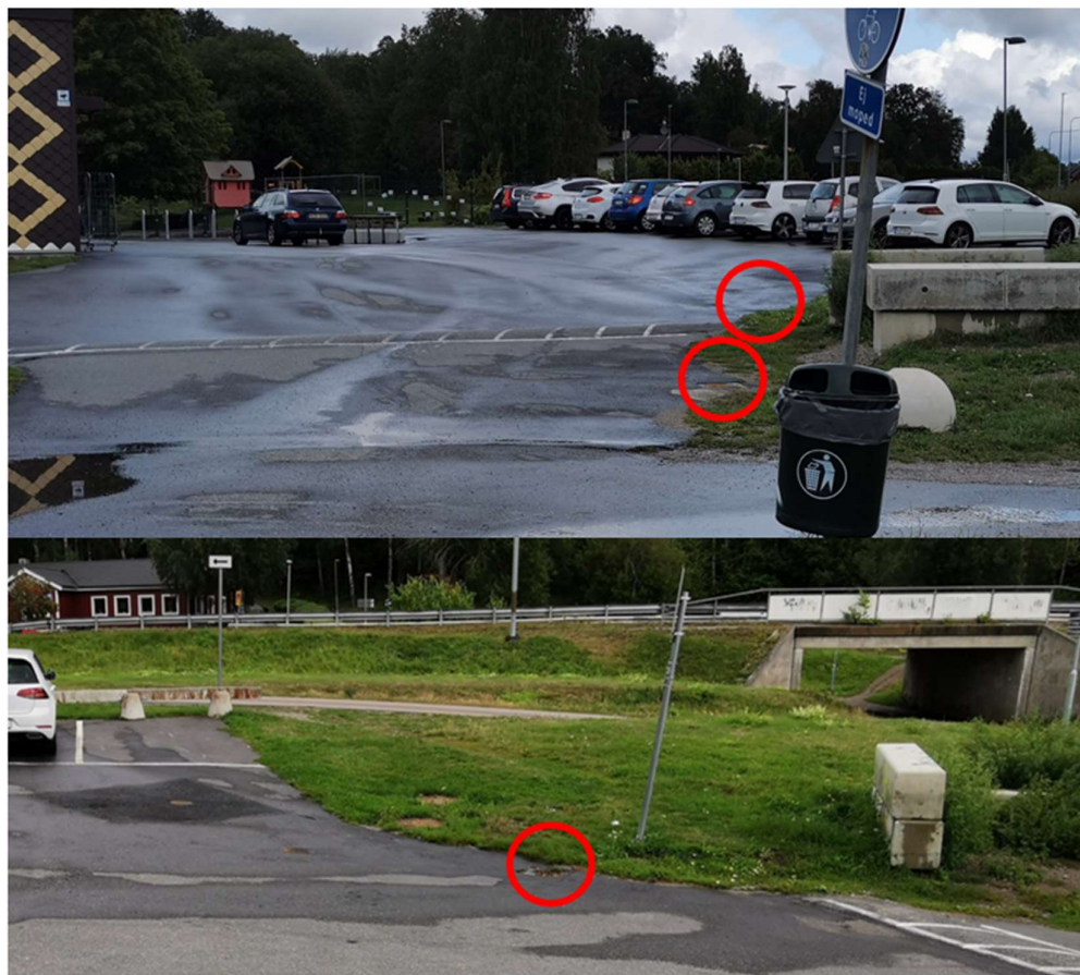
Figur 8. Dagvatten från bilparkeringen avrinner direkt till dagvattenbrunnar inom planområdet.
